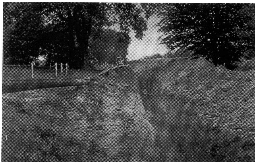
Fig. 2: Overzicht van het terrein tijdens de uitvoering van de werkzaamheden.
