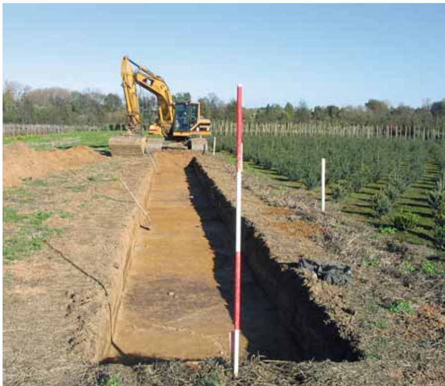
Afb. 11. De WML transportleiding doorsneed ten westen van Kelmond het Bandkeramisch nederzettingsterrein Kelmond 2.
