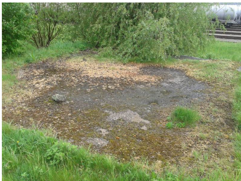
Betonnen deksel schacht 1
