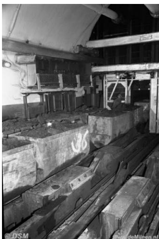
Verlaadplaats bij schacht
