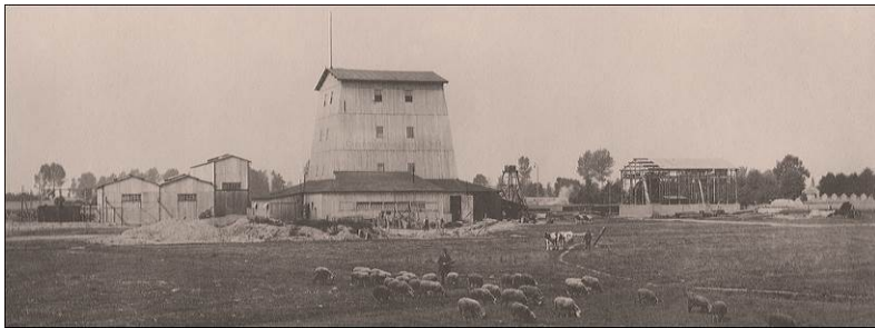
De boortoren voor het afdiepen van schacht I van de Staatsmijn Maurits in 1916
