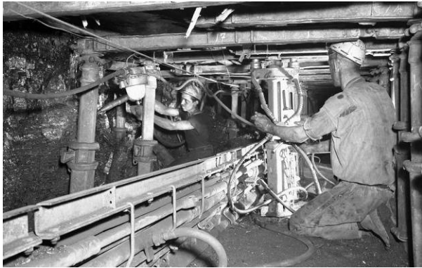
Een houwer bezig met afbouwhamer en de andere met het plaatsen stijlen.
